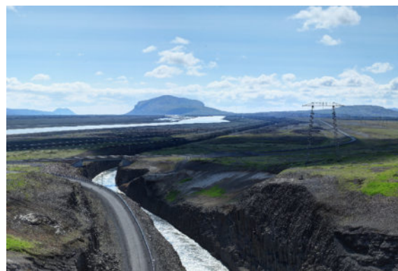
Mynd 68. Ljósmynd F tekin til suðurs frá Sultangavirkjun yfir frárennslisskurðinn og með Búrfell í bakgrunni.
