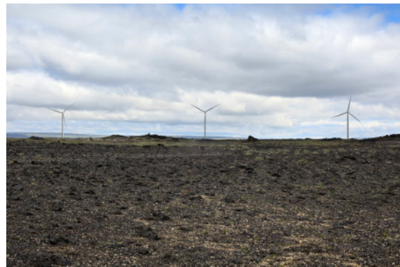
Mynd 114. Ljósmynd M tekin frá Dómadalsleið til norðurs og sýnir 80 metra háar vindmyllur í 1,5 km fjarlægð.
